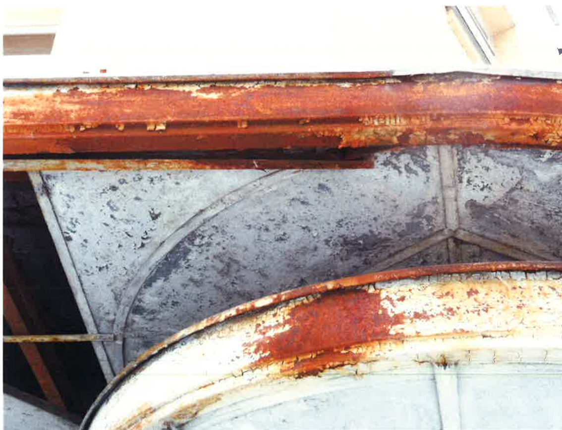
FOTO 16: Poškozené profily L – prvky lemování
