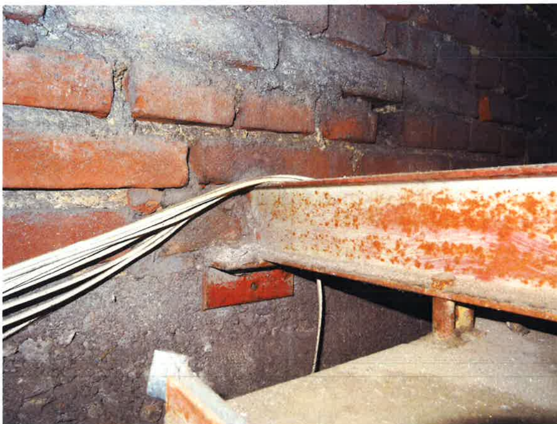
FOTO 04: Uložení konzoly I 100 do zdiva – povrchová koroze
