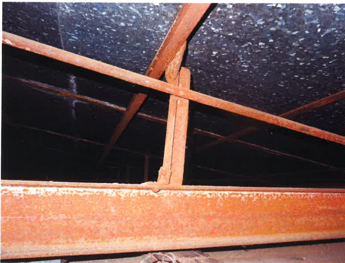
FOTO 05: Podélný profil U 40 a detail uchycení
