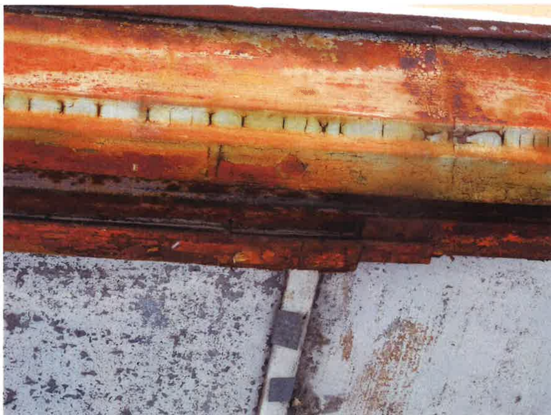
FOTO 15: Poškozené profily L – prvky lemování
