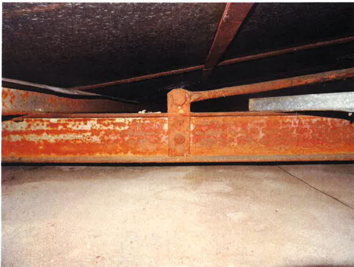
FOTO 07: Detail připojení táhla k I 100
